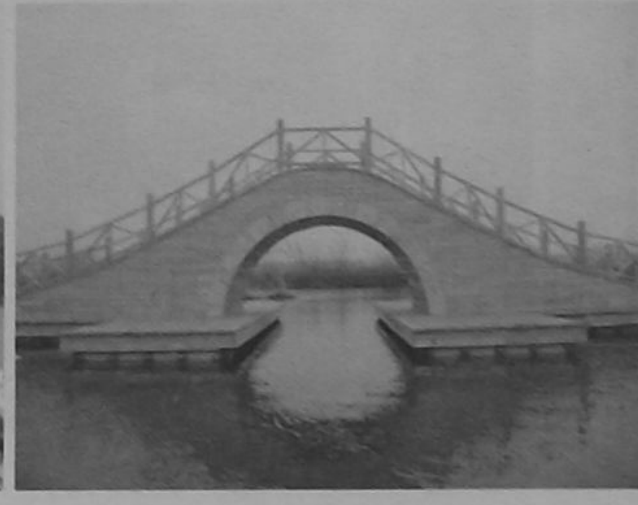
木拱通行浮桥
