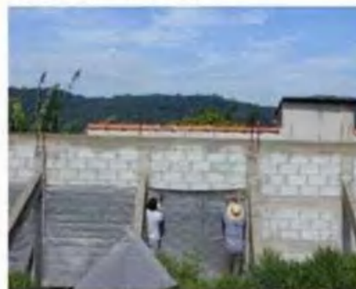
挡墙排水实景照片
