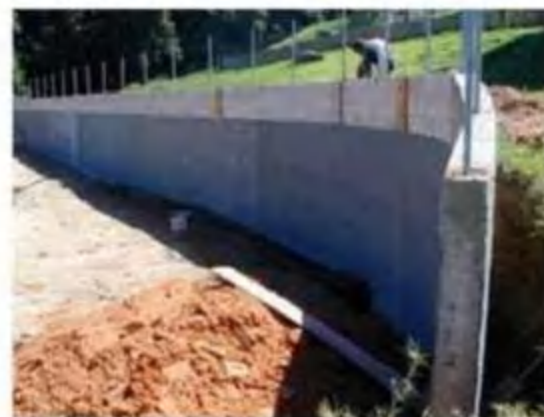
挡墙排水实景照片
