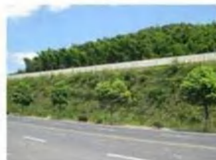
绿色加筋格宾挡墙实景照片
