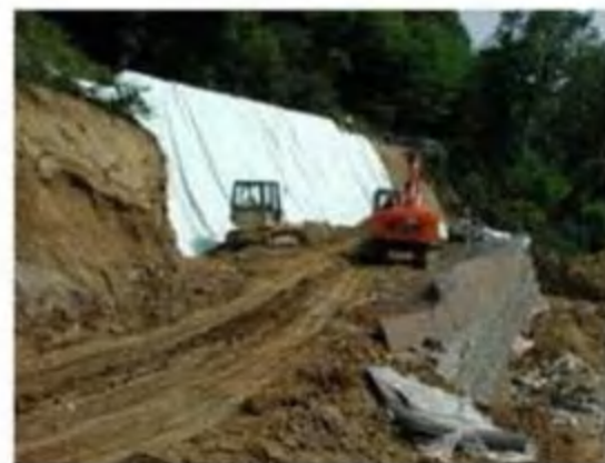
加筋土挡墙排水实景照片
