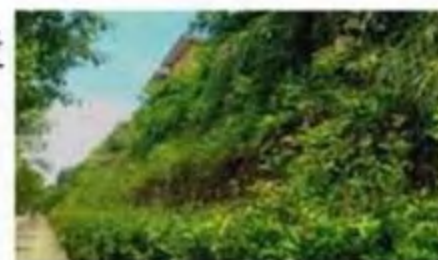
复合加筋格宾挡墙实景照片
