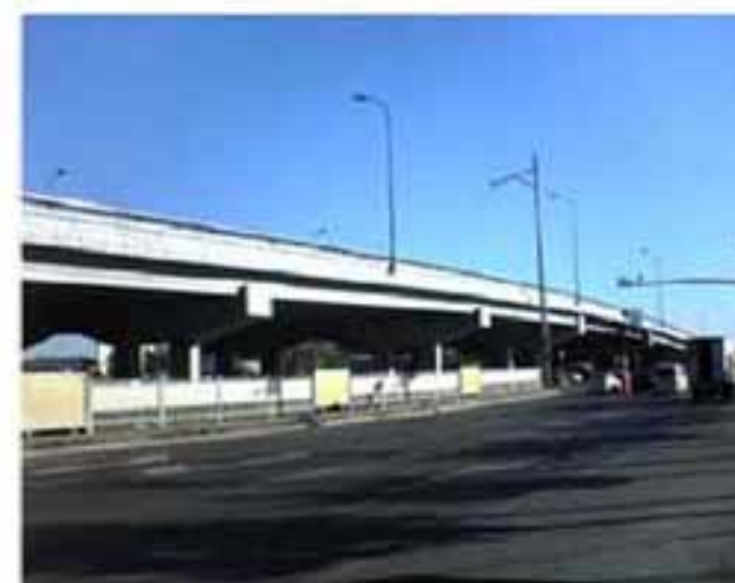
2008奥运会二、三、四环立交桥桥梁粉刷
