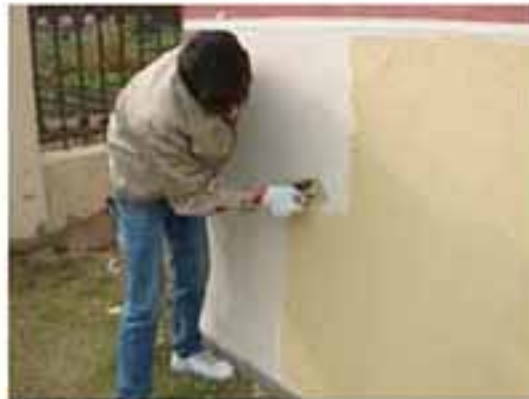
无机饰面砂浆刮抹
