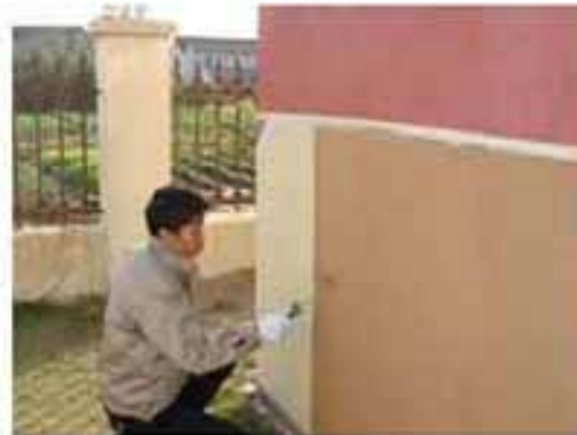
无机粉末涂料施工
